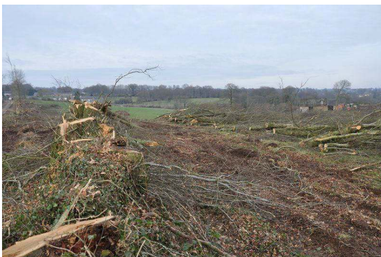
Illustration 2 : Chantier « clé en main » - Orne.
