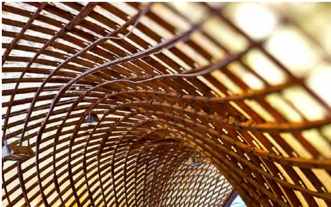
Structure bois du pavillon de Mannheim - Allemagne, 1975 Photographe : Raul Lieberwirth Architecte : Frei Otto Ingénieur : Ove Arup
