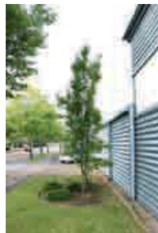
Ici un arbre planté trop près du mur.
