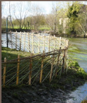
Maintien de berge Asnières-sur-Vègre (72)
